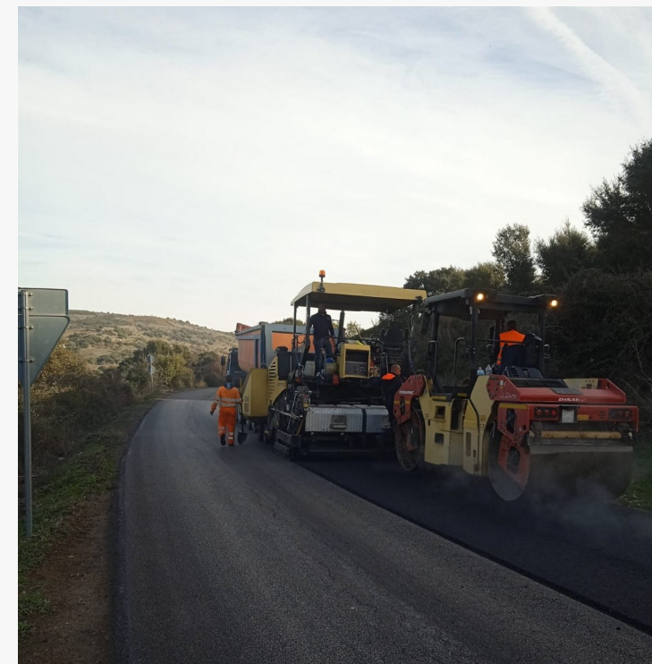
CANTIERE 03 Finitura della pavimentazione
