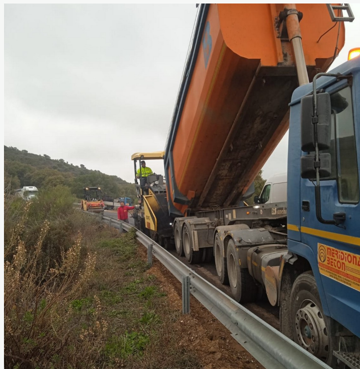
CANTIERE 02 Stesa del conglomerato
