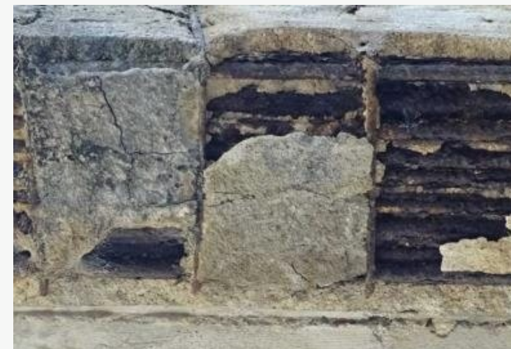
OPERA 03 Armature esposte
