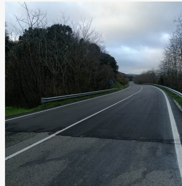
RISULTATO 03 Intervento concluso
