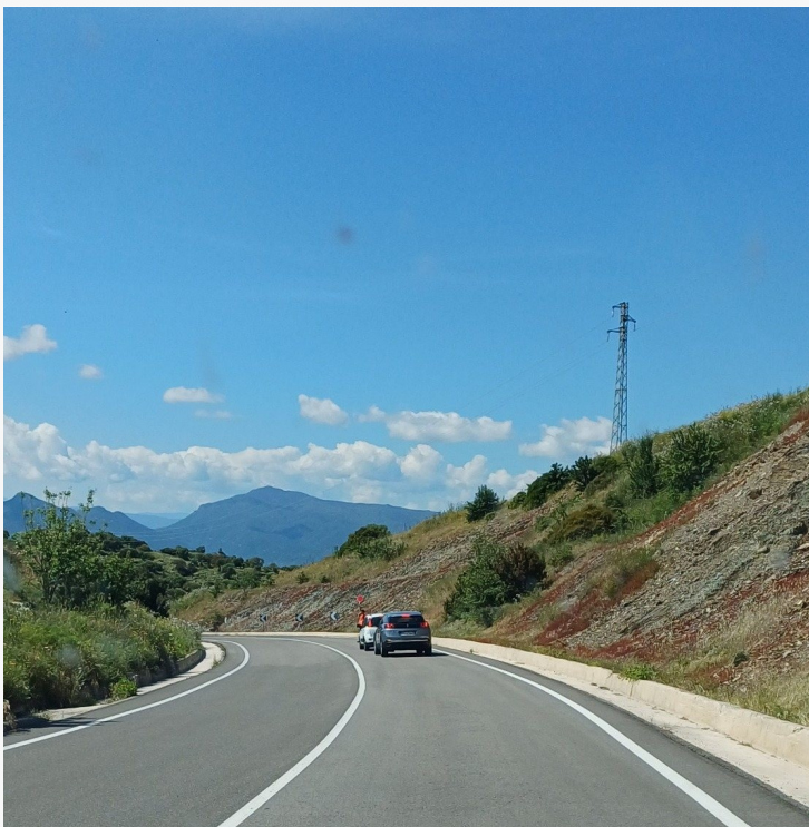
RISULTATO 01 Pavimentazione riqualificata
