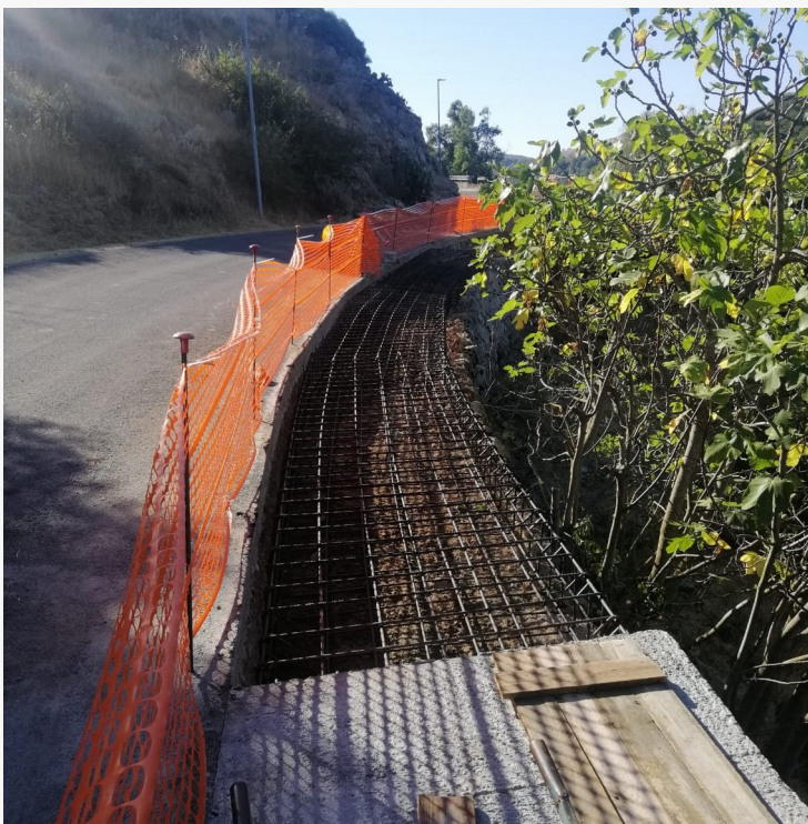
CANTIERE 01 Opere laterali alla strada
